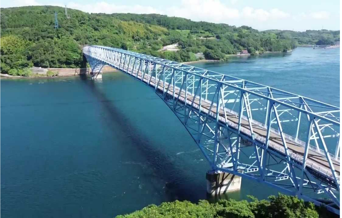
ドローンから撮影した黒之瀬戸大橋
