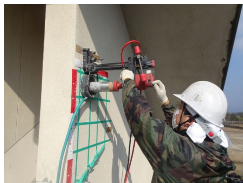
コアボーリング作業中
