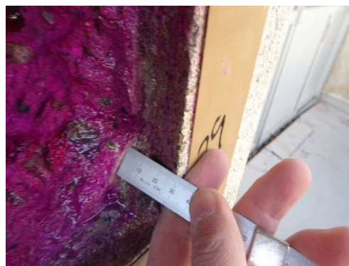
はつり箇所での中性化試験
