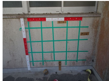
鉄筋位置の推測 (緑テープ箇所)
