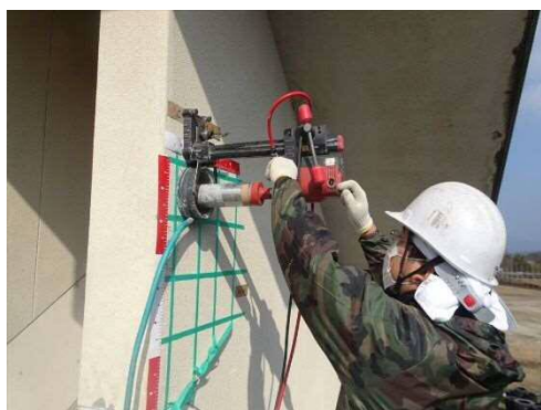
コアボーリング作業中
