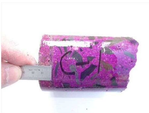
コアによる中性化試験
