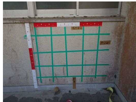
鉄筋位置の推測（緑テープ箇所）
