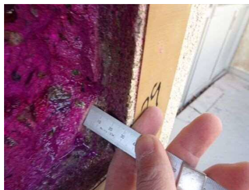
はつり箇所での中性化試験
