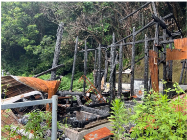
現況写真①
