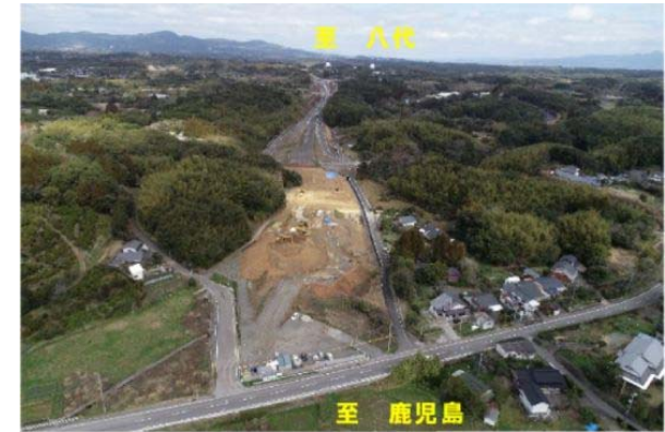
阿久根IC付近 施工状況
