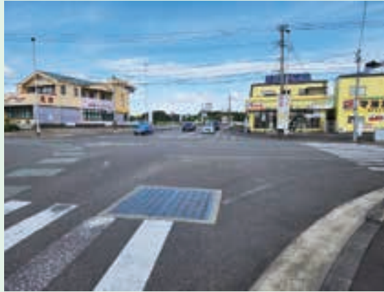
国道3号と交わる国道389号。一日中多くの車が通行しており、環境美化を含めた通年での管理が必要。
