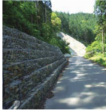
整備された林道とのり面
