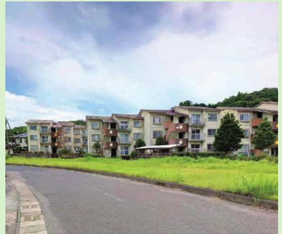
外部改修工事に伴うアスベスト含有調査を実施する市営ふれあい住宅
