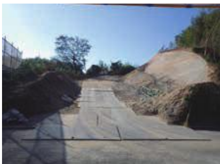
不動下線道路改良工事の様子 (波留区)
