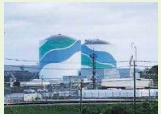
阿久根市街地から僅か20km、車で30分の所にある稼働中の川内原発
