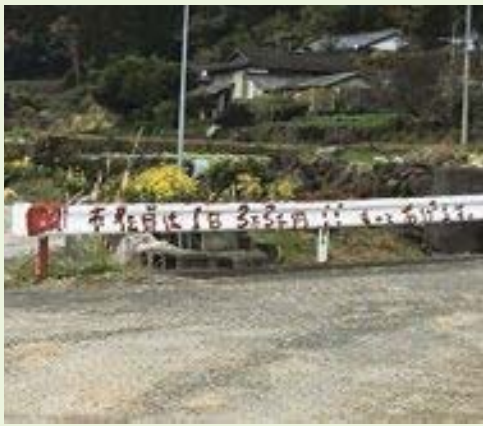
落書きがしてあるガードレール
