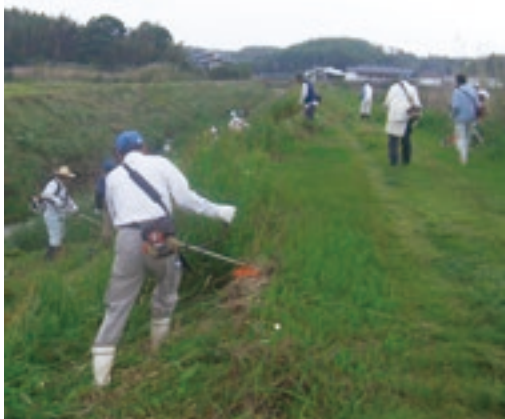
内田集落の伐開状況
