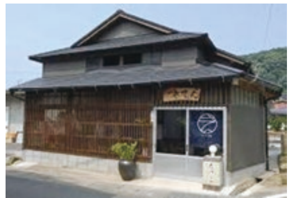
空き家を再生し地域の交流拠点に（大川）
