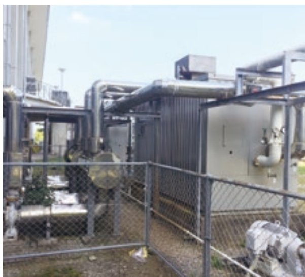
修繕が予定されている総合体育館の空調機器
