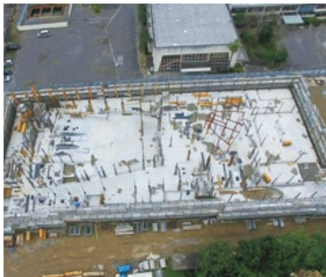
市民交流センターの建設状況（9月）
