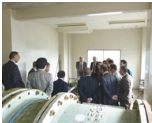
折多排水機場での現地調査の様子
