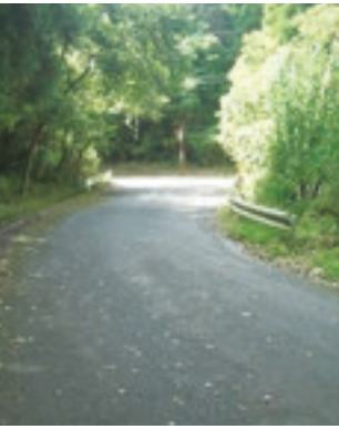
中央線、落区周辺の一次改良区間
