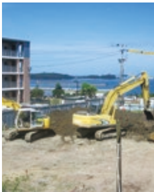
建築工事が進む 寺山住宅6号棟
