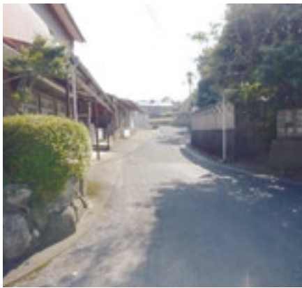
改修が行われる赤瀬川の出口線
