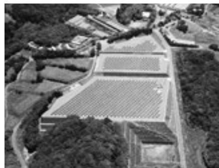
桑原城ソーラー発電所
