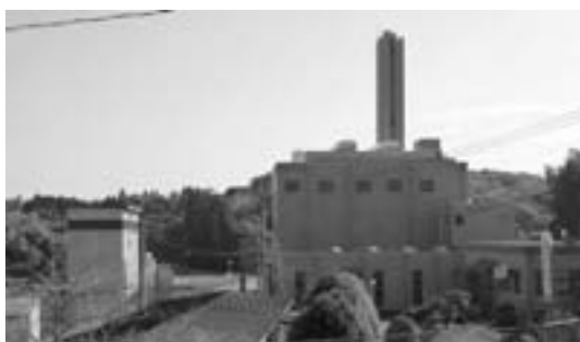
丸内地区の環境センター
