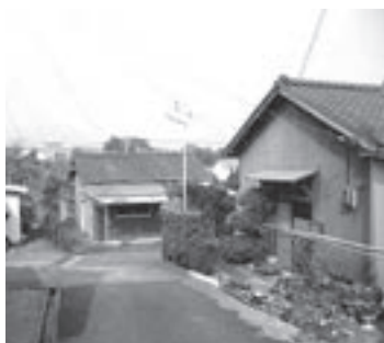
老朽化が進んでいる市営住宅
