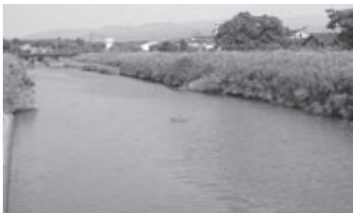
改修工事が急がれる折口川
