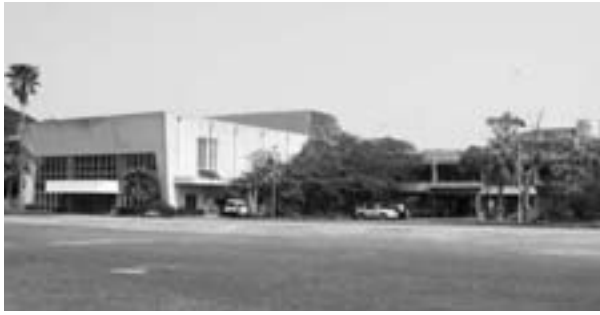
建設から41年を経過した市民会館
