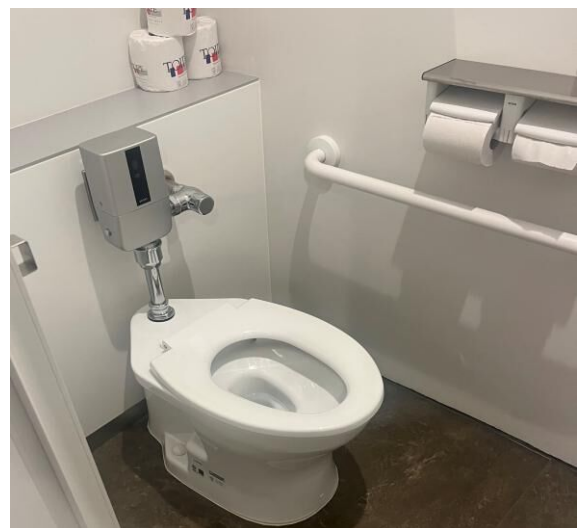
洗浄便座のない楽屋・ホール側トイレ
