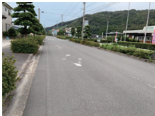
道路の中央線がわからない
