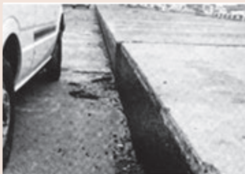
△岸壁の亀裂や水揚げ場に大きな被害（阿久根港）
