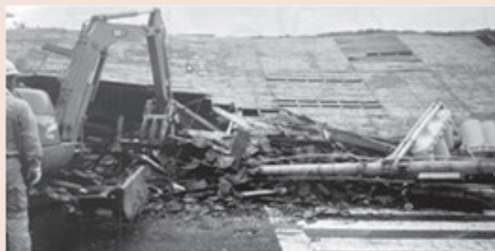
△全壊した民家と折れた信号機
