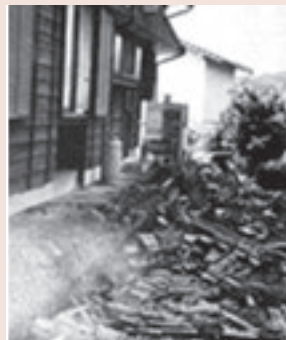
△屋根瓦が散乱した住家
