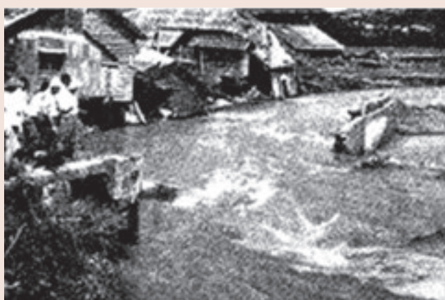
△浜田橋の堤防決壊
