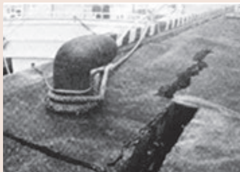
△岸壁の亀裂や水揚げ場に大きな被害（阿久根港）
