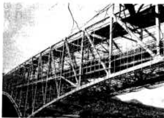
大がかりな塗装工事が行われている黒之瀬戸大橋
