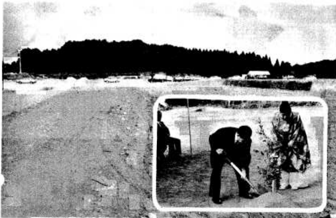
広々とした農林業振興センター建設用地と工事の安全を願ってクワ入れを行う新柳市長
