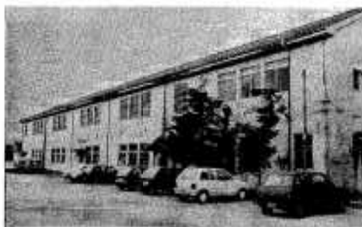
改築される阿久根小学校の危険校舎
