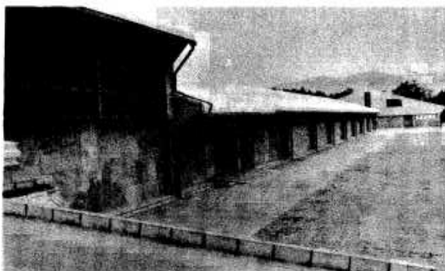
完成した大規模な堆肥舎
