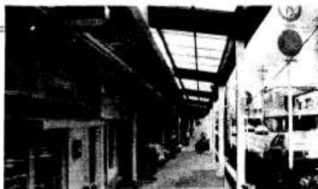
「魅力ある商店街」づくりをめざして アーケードの全面改修を急ぐ大丸町商店街
