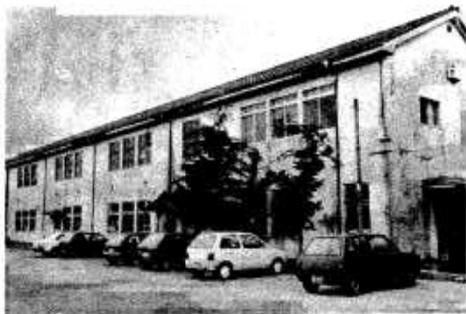
「子どもたちが安心して勉強できるように」 新校舎を建設 (写真は改築される阿久根小学校の危険校舎)
