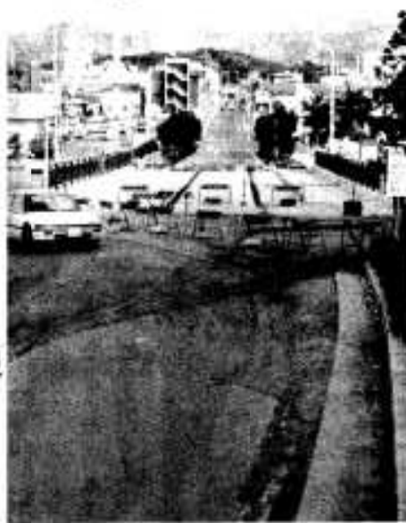
9月完成予定の新塘橋
