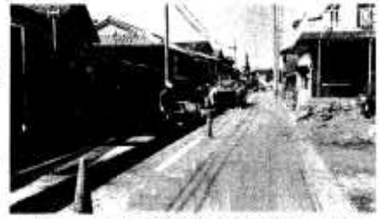
急ピッチで工事が進められる上野都市下水路
