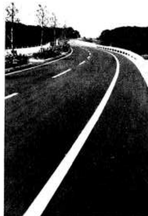
完成した脇本バイパス
