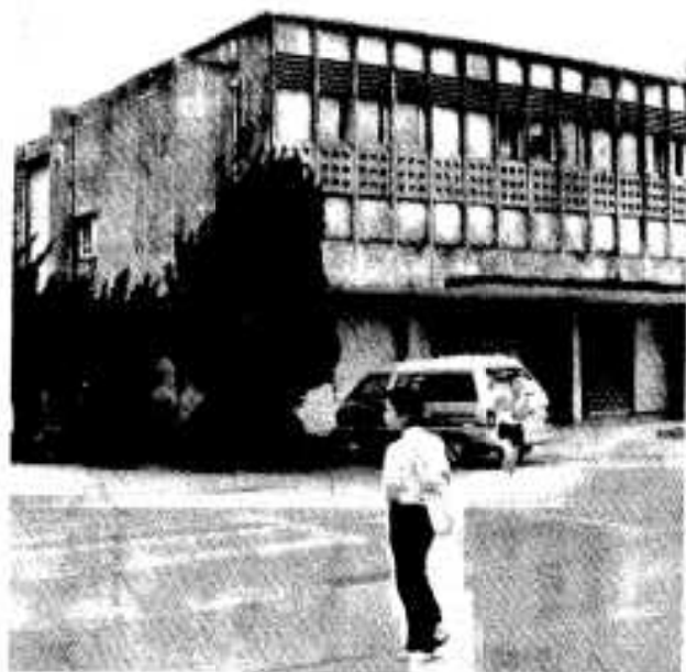
改築される阿久根中の屋内運動場
