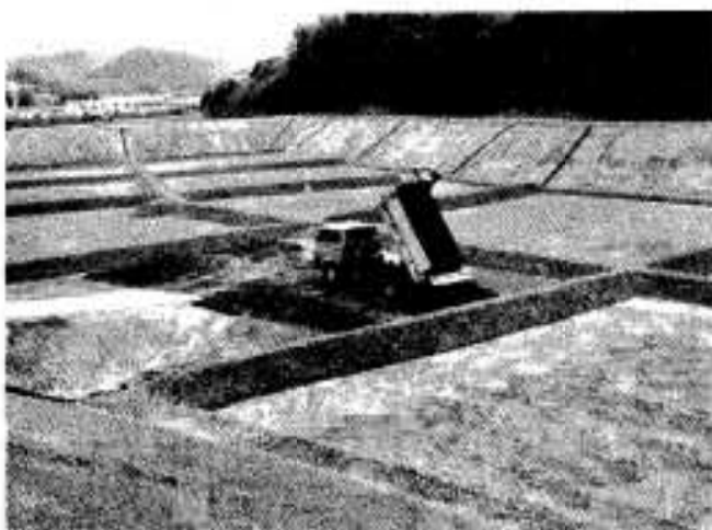
完成した最終処分場
