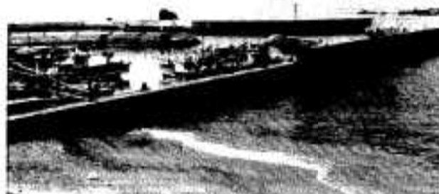
漁港・港湾の改良整備（牛之浜漁港）
