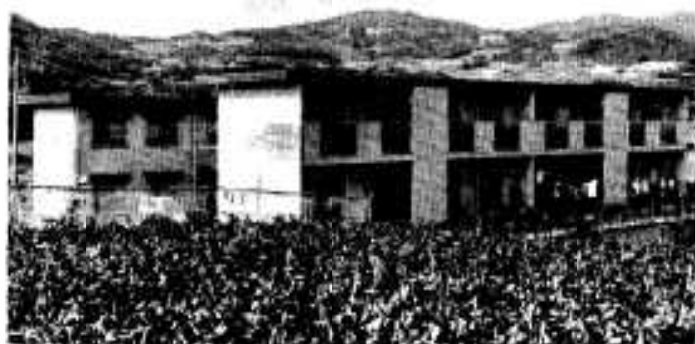
一部簡易保険の資金を受けて建設された上原市営住宅
