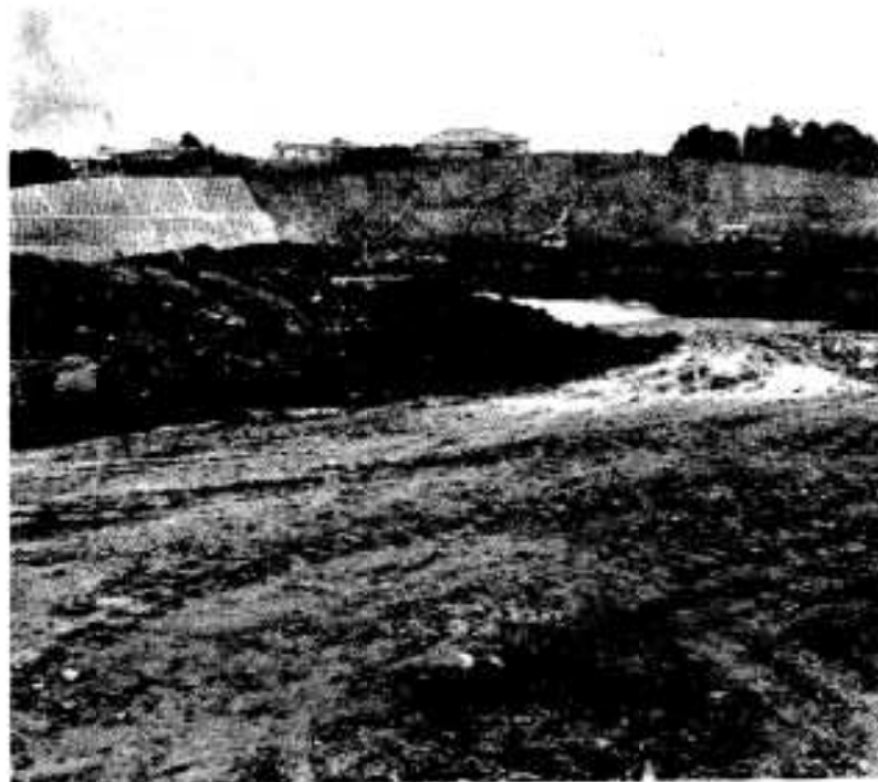
急ピッチで工事が進む野球場
