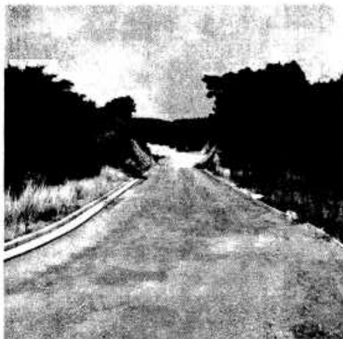
舗装改良される高之口地区農道
