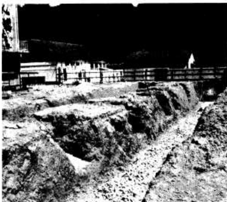
基礎工事が始まった鶴川内小学校新校舎
