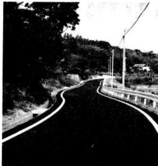
ガードレールもとりつけられ改良された赤瀬川線
