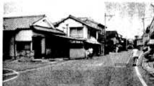
本年度下水路工事に着手する 後半田踏切付近(栄町)
