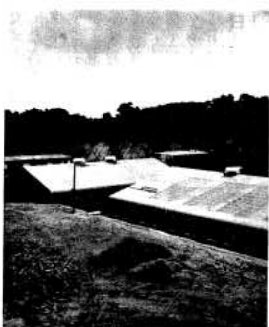
工事中の栽培漁業センター
