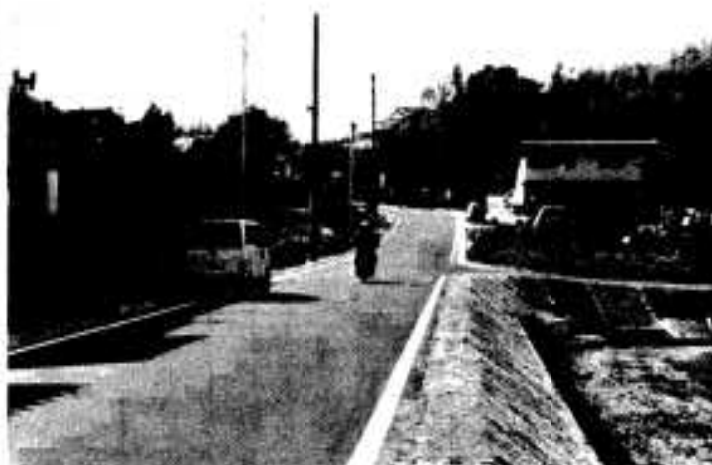
改良工事が完了した妻井田線(山下馬場)
