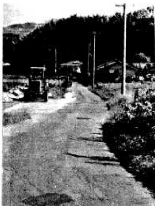
山下と波留を結ぶ、妻井田線の改良も始まります。
