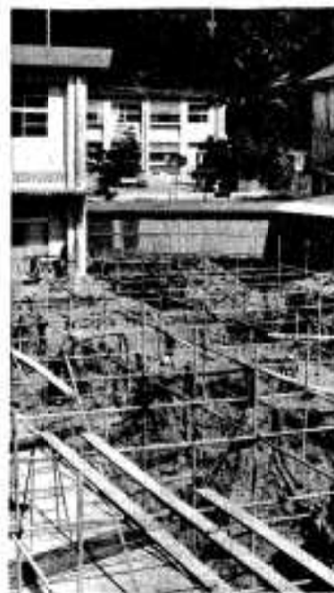
工事が始まった大川中
