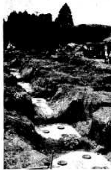
基礎工事が始まった山下小
