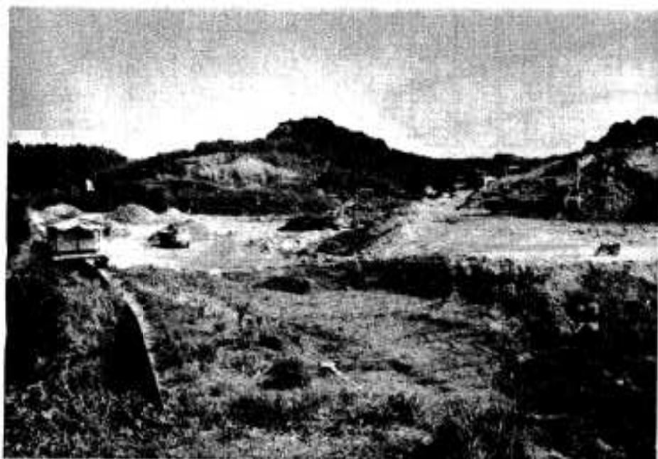
造成工事が始まった大川島の現場
