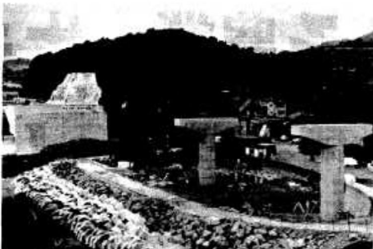
橋脚が工事中……尻無バイパス
