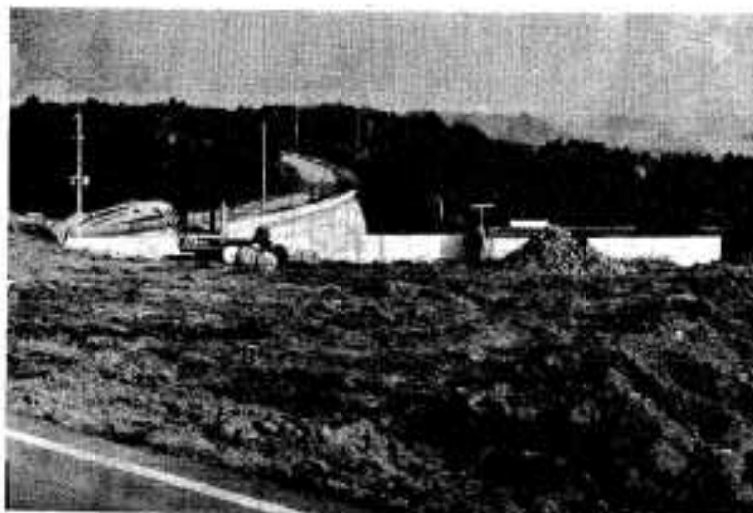
造成が始まった工場建設予定地 （協本上原区）
