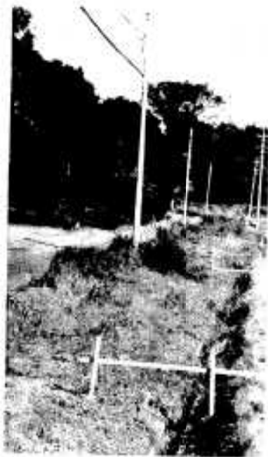
拡幅のためのクイ打ちも終り 工事が始まる
