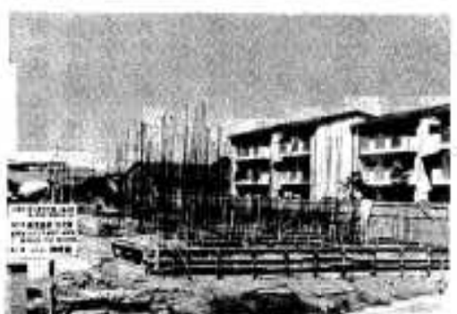
建設中の県営住宅
