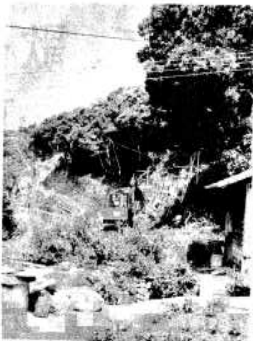
急傾斜を削り工事が進む
