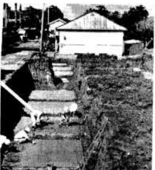
土留のコンクリート打ちも始まる——三笠中学校
