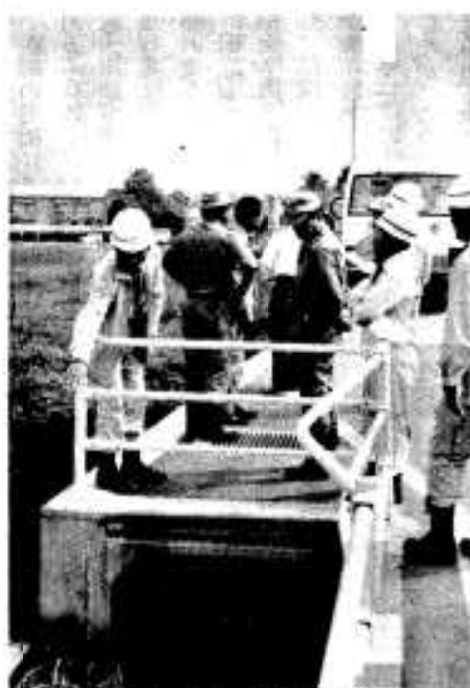
湯地区の排水路を点検
