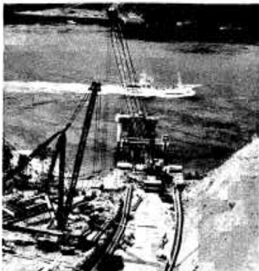
いよいよ本体工事に着手
