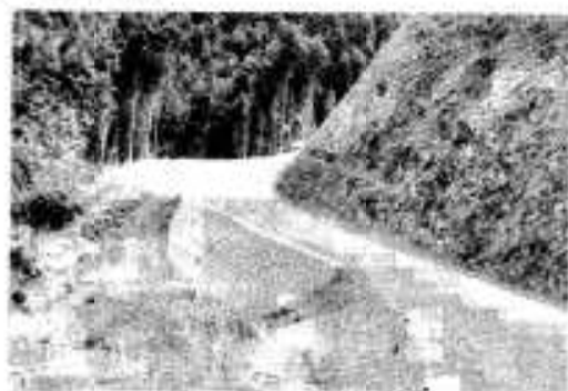
紫尾林道と結ぶ林道仁床線も開通
