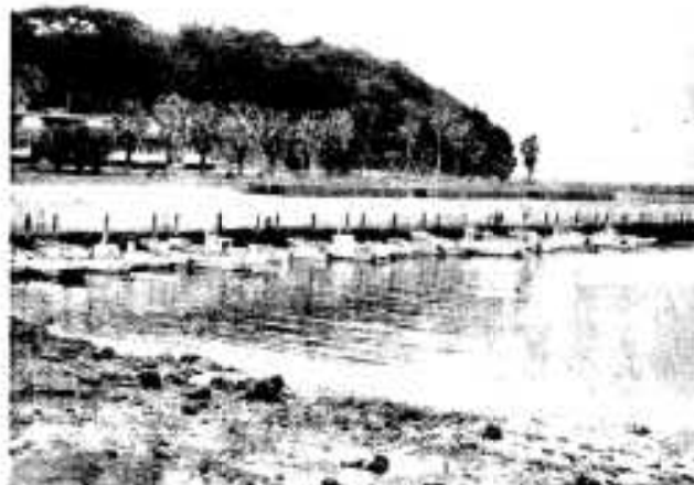
港の整備も急ピッチ。護岸が完成した高之口港
