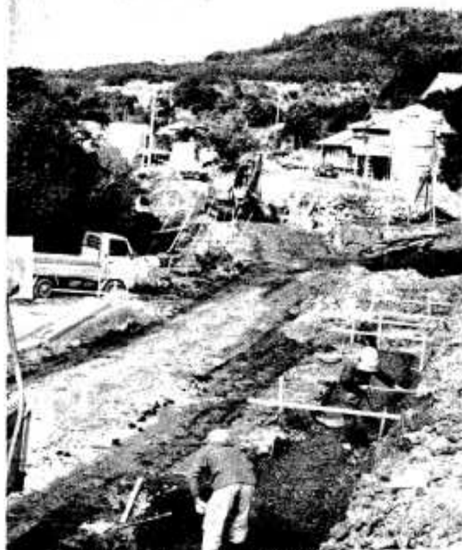
改良が始まった古里松ヶ根線（松ヶ根区内）
