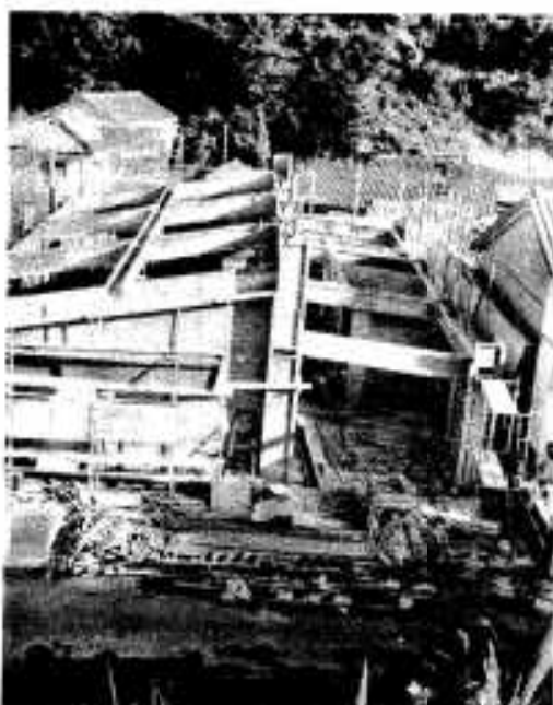
建設が始まった漁民研修施設
