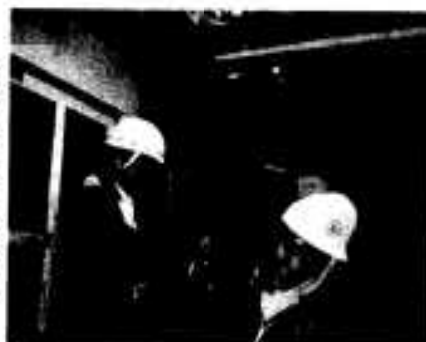
雨の中、修理の奉仕
