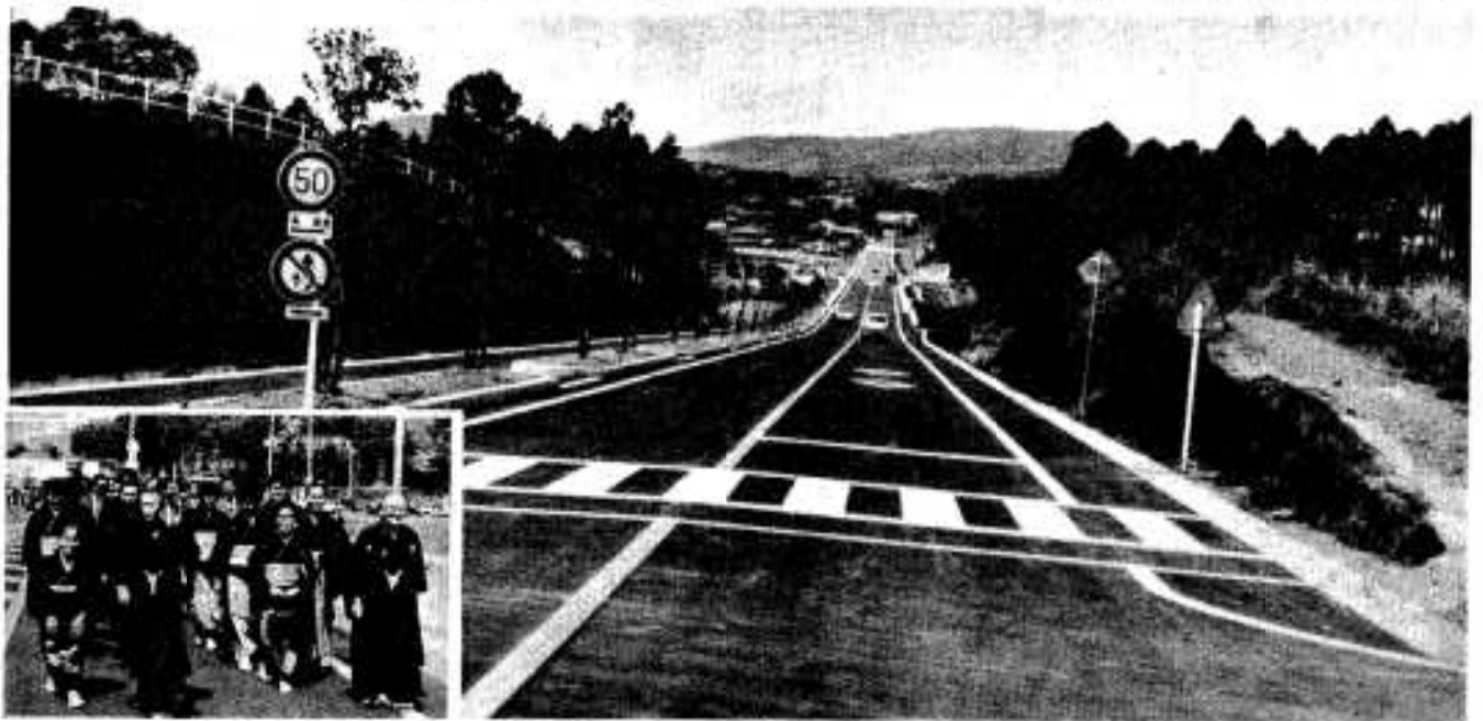
国道389号バイパス一部開通…このほど、扇本山仁田から下村までが開通。4月5日扇本大橋の渡りぞめが行われました。
