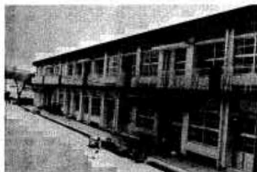
折多小校舎…工事費一億三、六六〇万円で全面改装。近代的な学校になりました。
