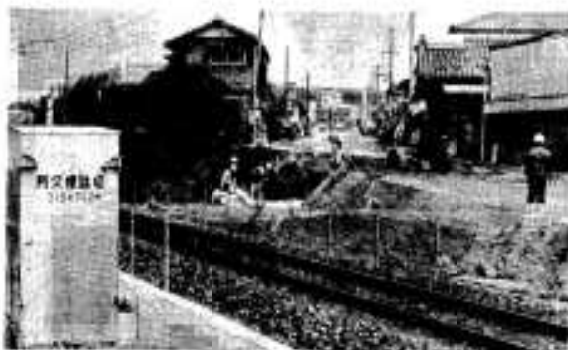
上野都市下水道も工事が進む
