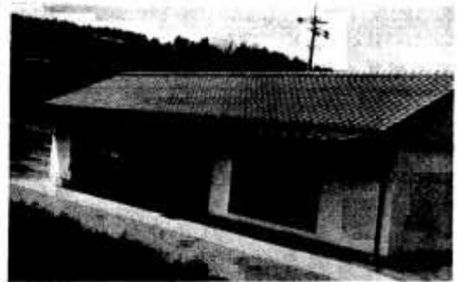
大漕集会施設…林業構造改善事業で昨年12月着工。このほど完成。工事費 947万円、112平方メートル。
