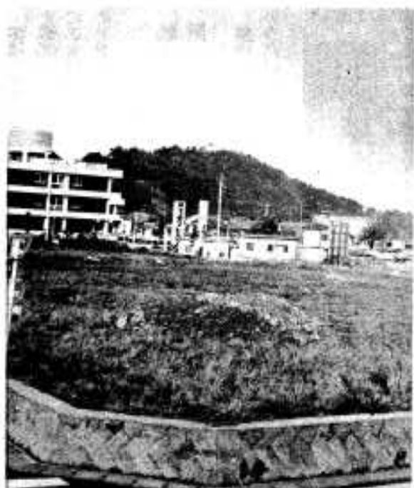
遊具設置工事が始まる鶴見公園
